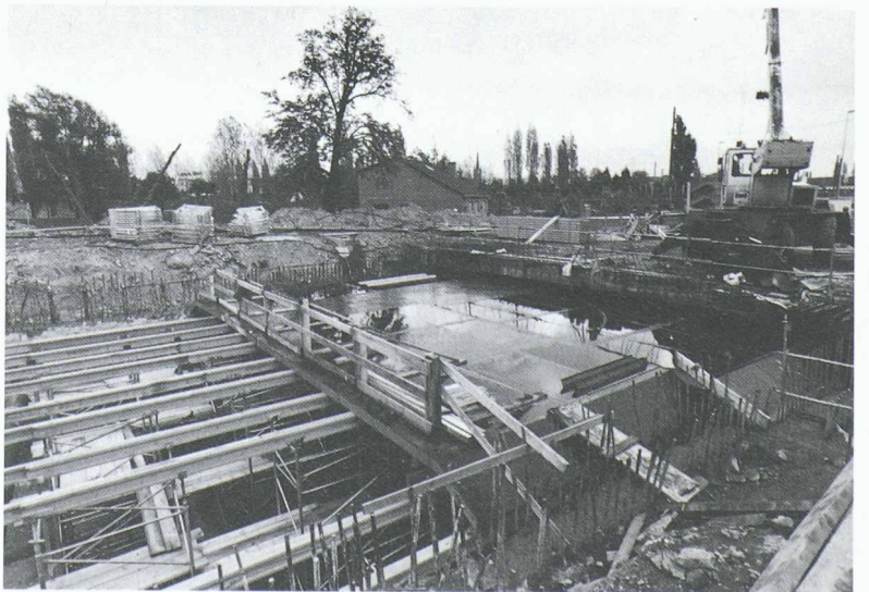
Fig. 9 et 10. – Travaux de bétonnage à l'aide de coffrages se déplaçant sur rails.
