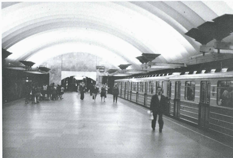
Une station des années septante au style dépouillé du métro de Leningrad. Grâce à l'éclairage indirect dirigé sur la grande voûte, un certain aspect monumental demeure. A noter la grande largeur du quai médian. Train du type E.
