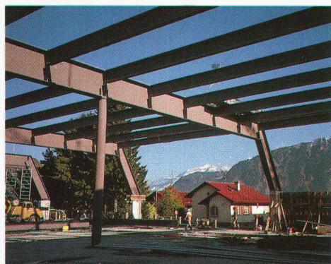
Exemple de construction avec des POUTRES COMPOSEES SOUDEES
