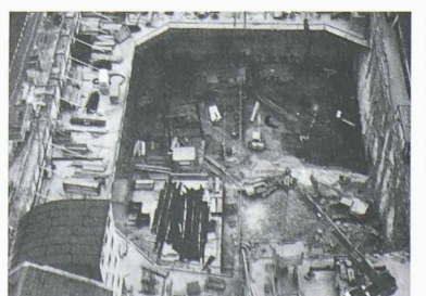
Fig. 9. – Bétonnage de l'anneau de compression, 2 e étape, août 1991
