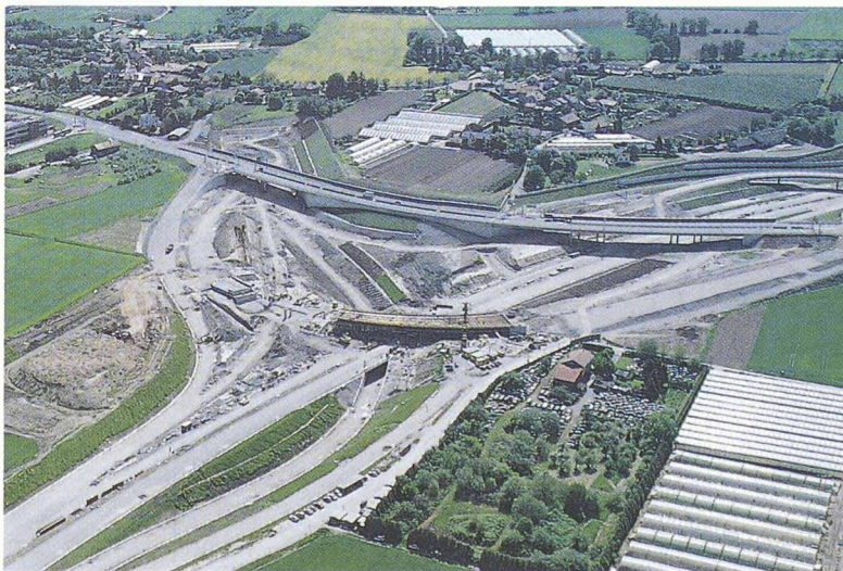
Fig. 5. – Echangeur-jonction de Perly: vue du chantier
