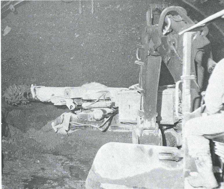
Fig. 3. – Avancement en calotte du côté Canada, attente de la pelle hydraulique pendant l'abattage à la machine à attaque ponctuelle
