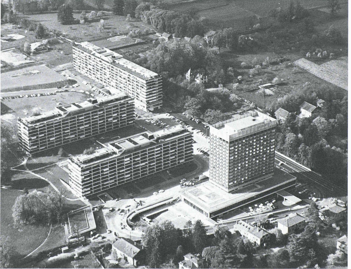
Le parc de Budé, 1958-1962. Addor et Julliard, associés à Honegger Frères, architectes et ingénieurs. Document archives Julliard et Bolliger SA, architectes
