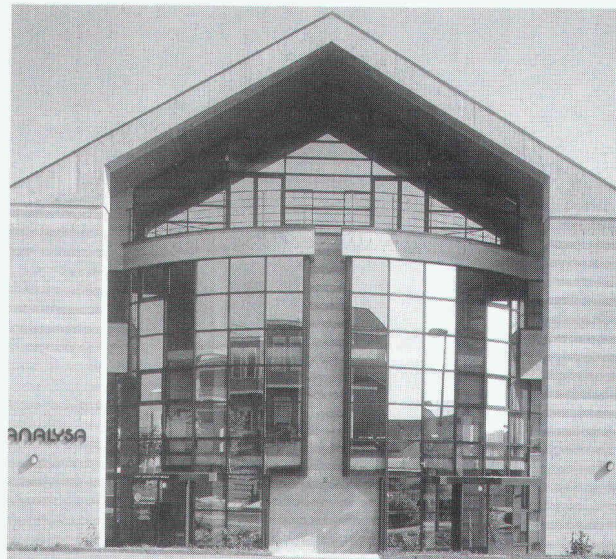
Bâtiment administratif Analyza SA, Yverdon
