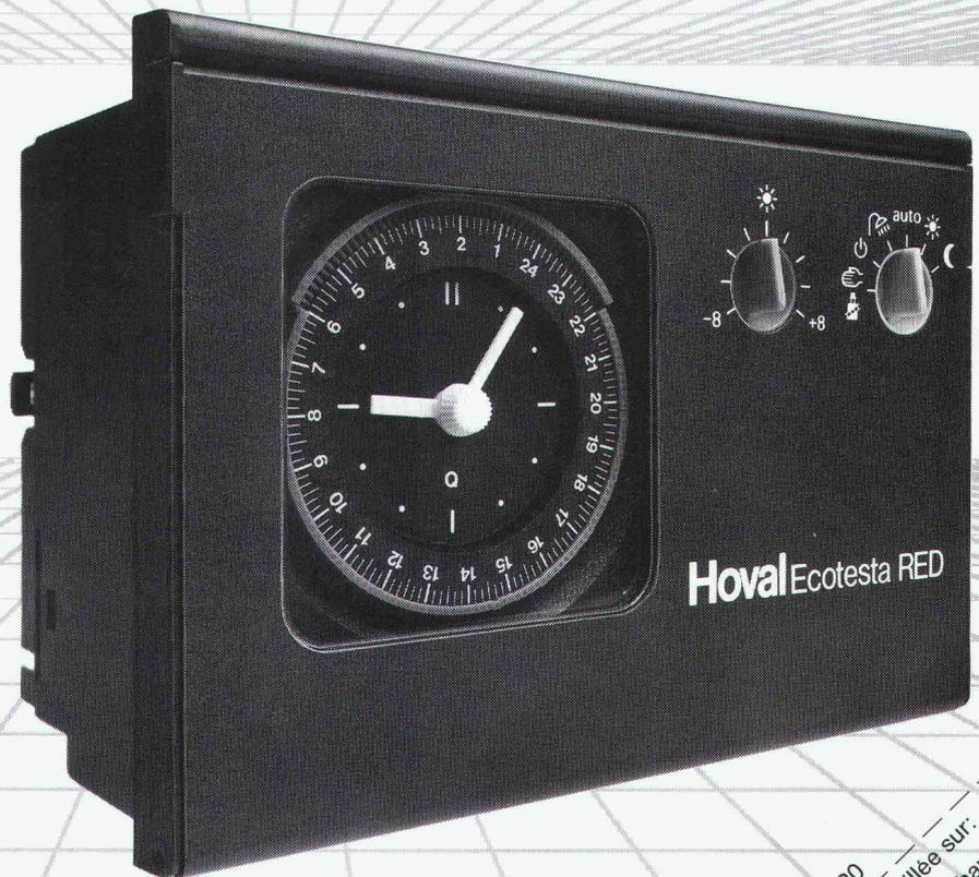
Le nouveau régulateur de chauffage Hoval Ecotesta est équipé d'une horloge mécanique, d'un commutateur rotatif pour sélection de programme, d'un réglage de valeur de consigne et d'un champ d'informations digitales pour le spécialiste.
