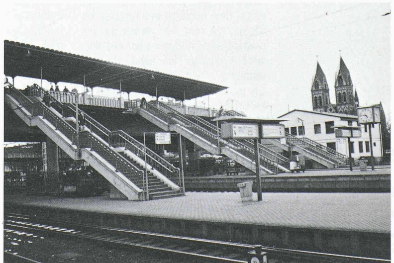
Fig. 13. – En gare de Fribourg-en-Brigau: le passage du tram au train est assuré par une batterie d'escaliers reliant la station VAG aux quais de la DB.
