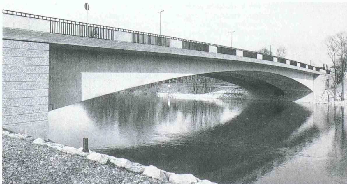
Pont de Hochzoll sur le Lech à Augsburg
