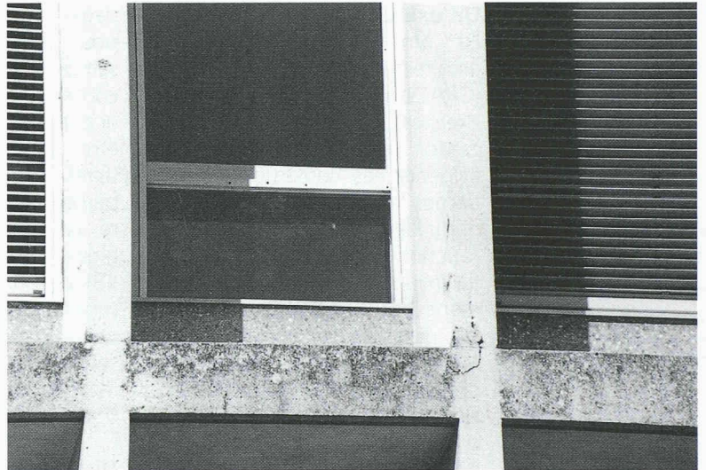
Photos de relevés de l'état existant des fenêtres
