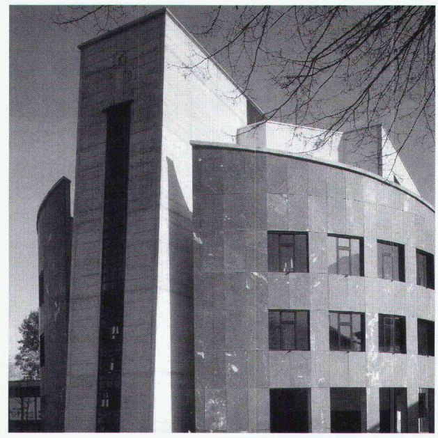
Bâtiment scolaire, Martigny
