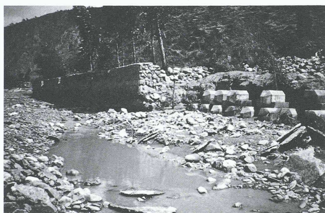
Fig. 13. – L'état de l'ouvrage le 12 octobre 1988
