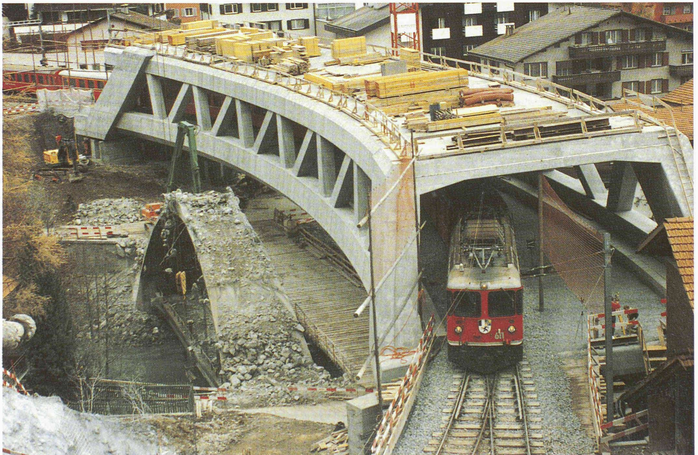
Fig. 15. – Encore à son emplacement provisoire, le nouveau pont est déjà en service, alors que l'ancien est en démolition
