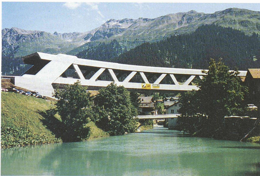
Fig. 13. – Nouveau pont avec passerelle en amont
