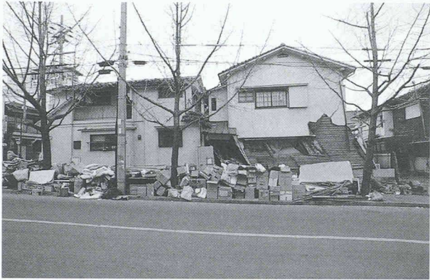
Fig. 14. – Maison en bois ayant basculé sur la gauche sous l'effet de soft-storey
