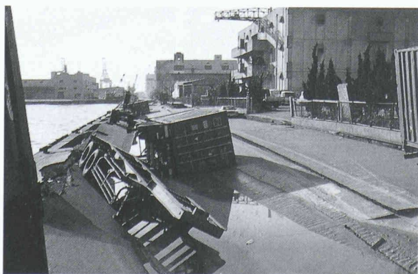
Fig. 5. – Déplacements horizontaux et verticaux du sol dus à la rupture d'un mur de quai dans le port de Port-Island
