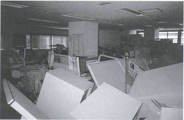
Fig. 16. – Mobilier renversé dans le bâtiment de la figure 15
