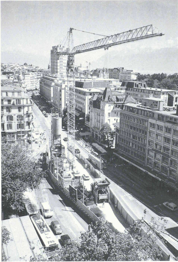
Fig. 16. – Place Chauderon: installations de chantier
