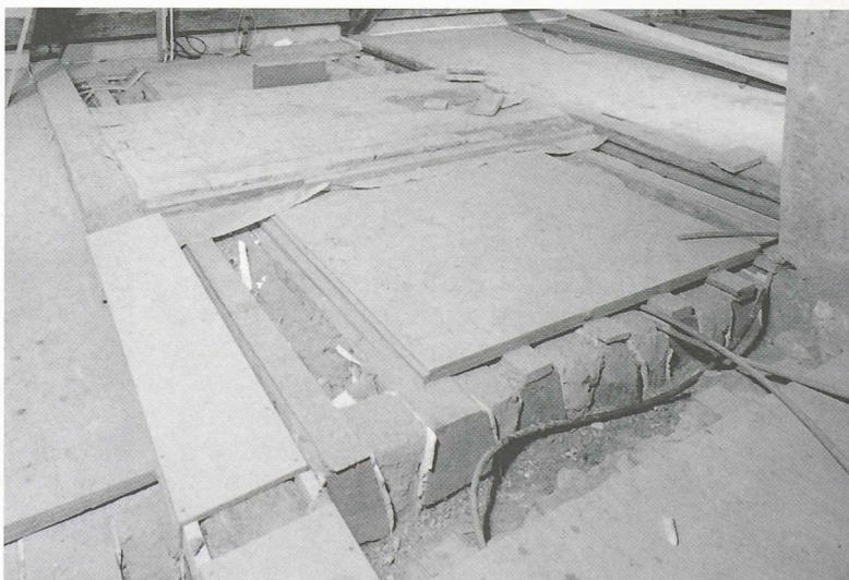
Combles: renforcement des planchers
