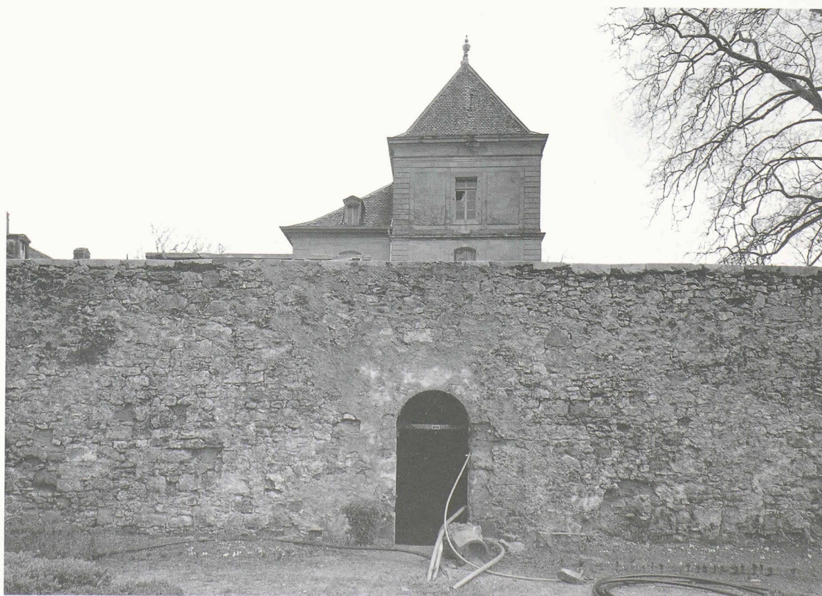
Mur de la terrasse ouest
