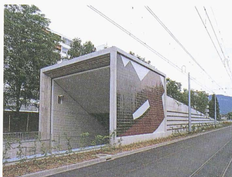
Les portails d'accès de la tranchée couverte des Palettes, de forme cubique, offrent une protection contre le bruit. Les plans inclinés qui les prolongent sont aménagés en «jardins suspendus» alors que leurs faces latérales sont revêtues d'émaux de grès colorés avec des terres naturelles. Chaque accès a une couleur dominante. (Photos: Mathias Thomann)
