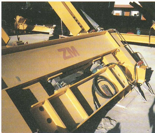
Pont de raccordement à la Voie-Centrale: calage
