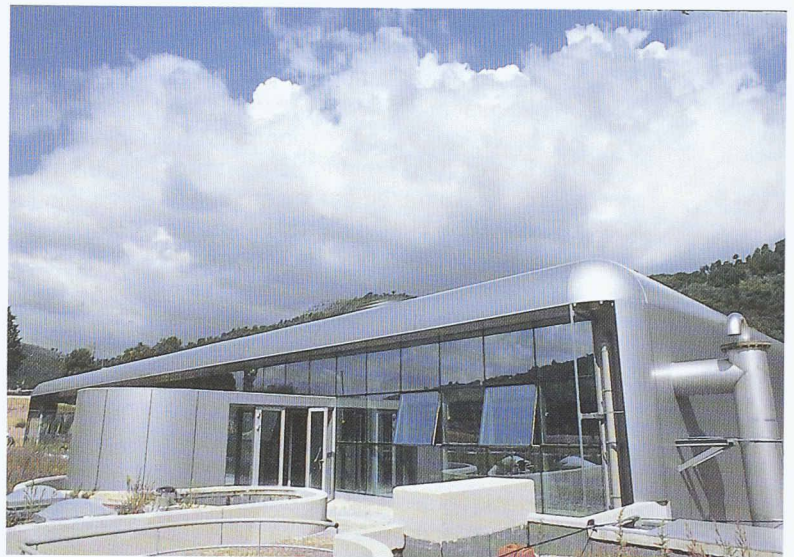
Usine d'ultrafiltration de l'Apié St-Cassien (Côte d'Azur) du Groupe Suez-Lyonnaise des Eaux, d'une capacité actuelle de 25 000 m 3 /jour, utilisant la technique membranaire d'ultrafiltration Aquasource similaire à celle prévue à Lutry
