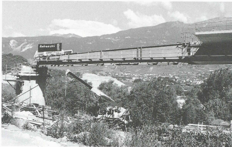
Fig. 10.- Avant-bec métallique
