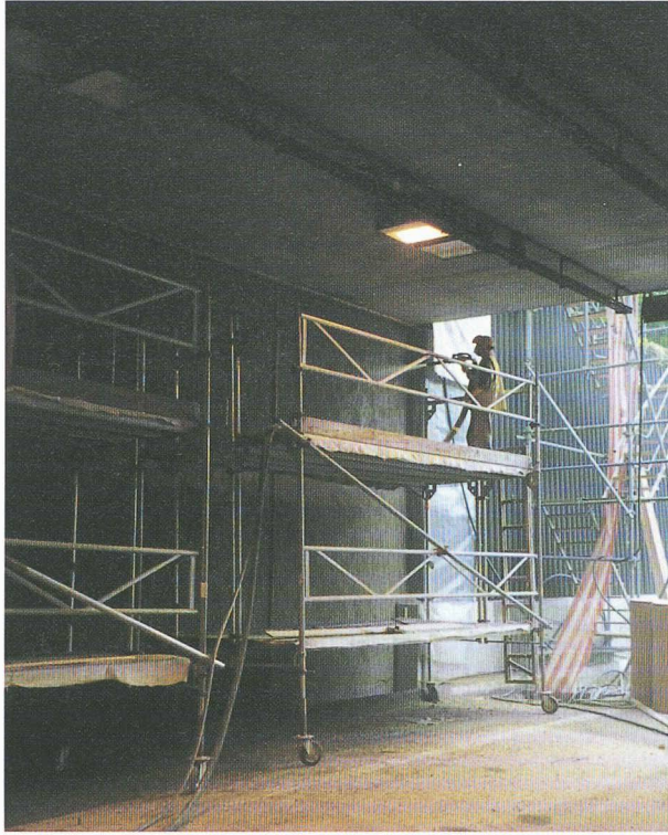
Fig. 6.- Enrobage du treillis par béton projeté
