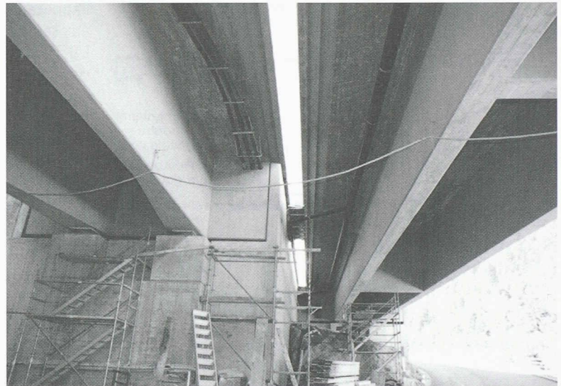
Fig. 7. - Nervures d'appui. Culée Sud du pont «Lora»
