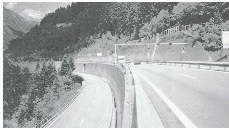
Fig. 13.- Murs et parois de soutènement, vue générale
