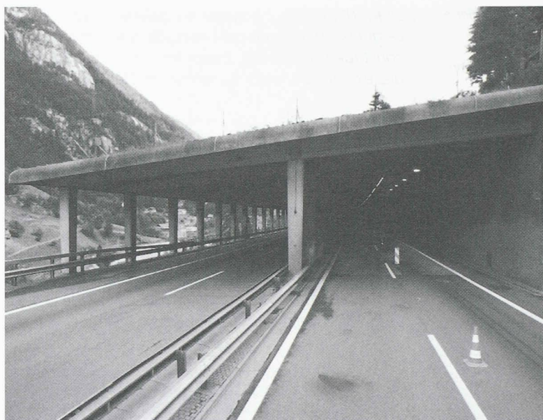
Fig. 3.- Galerie paravalanches de Willerplengen, portail Sud
