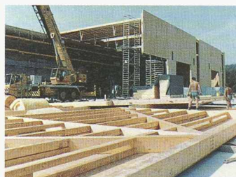
Rudolf ITA AG, Füllinstorf: la construction en bois moderne
