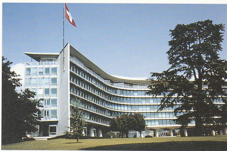
Fig.1. La façade sud du bâtiment de Jean Tschumi en 1960 (Archives Nestlé)
