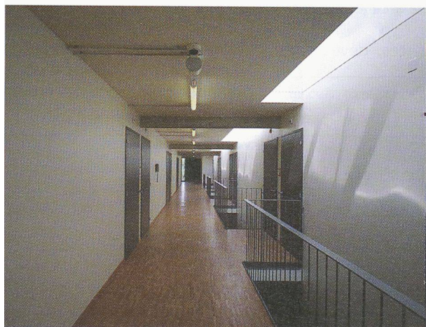
Fig. 6. Des lanterneaux assurent l'éclairage naturel des espaces de circulation (Photo François Bertin, Grandvaux)
