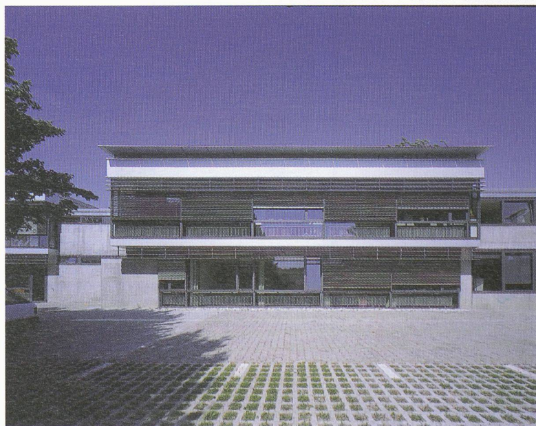
Fig. 3. Façade d'un pavillon après rénovation (Photo François Bertin, Grandvaux)
