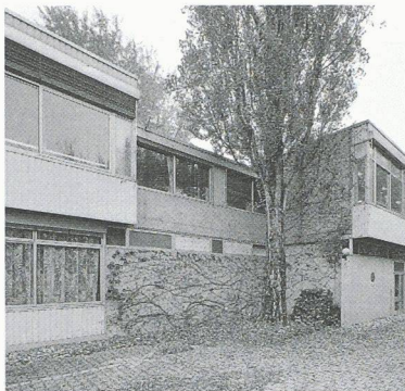
Fig. 1. Façade d'un pavillon, état initial (Photo François Bertin, Grandvaux)
