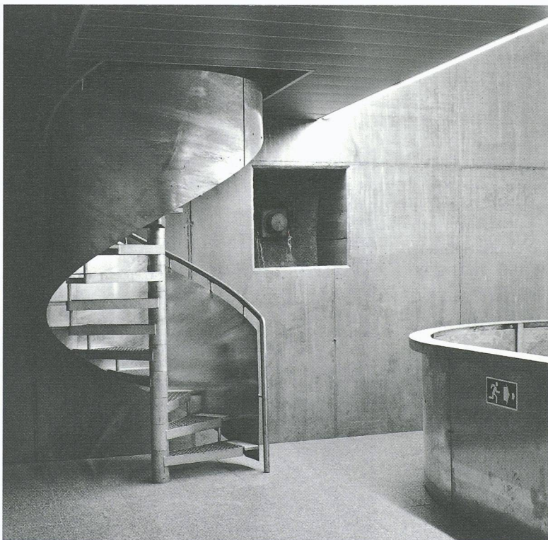
Fig. 5. - Éléments d'escaliers et garde-corps en acier zingué au feu (Photo Yves Eigenmann, Fribourg)
