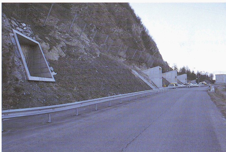
Fig. 9. - Portails des galeries d'accès (Photo bureau Lorenz-Musso, Sion)
