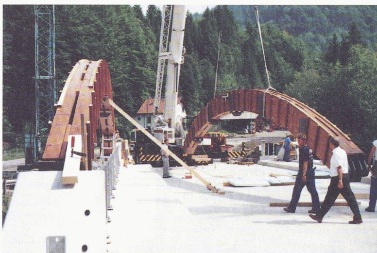
Fig. 6. – Montage des arcs à l'aide d'un camion-grue
