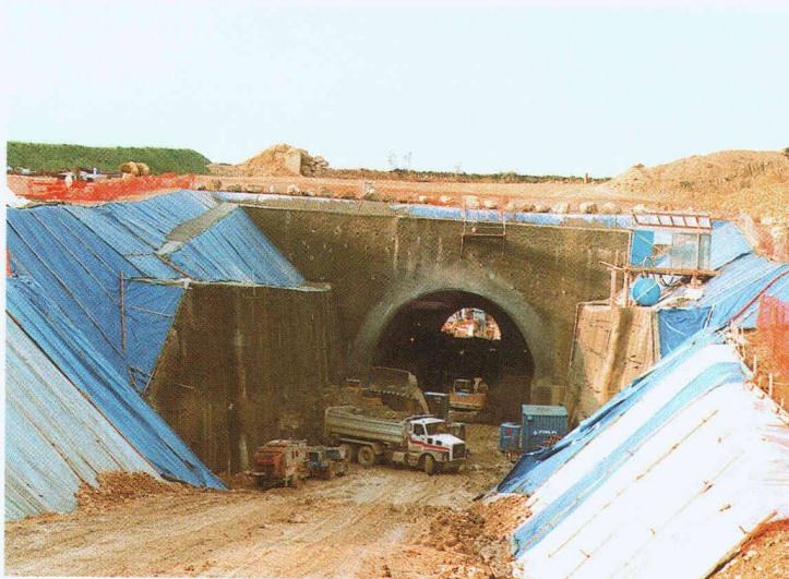
Portail ouest du tunnel de Fin-de-Lance (300 m)
