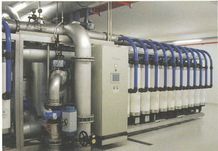
Fig. 2: Unité de production d'eau de Javel (Photo: Ville de Lausanne)
