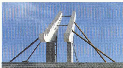
Poutres crémaillères du Stade de Suisse, au Wankdorf, 35 tonnes, précontrainte 4000 kN
