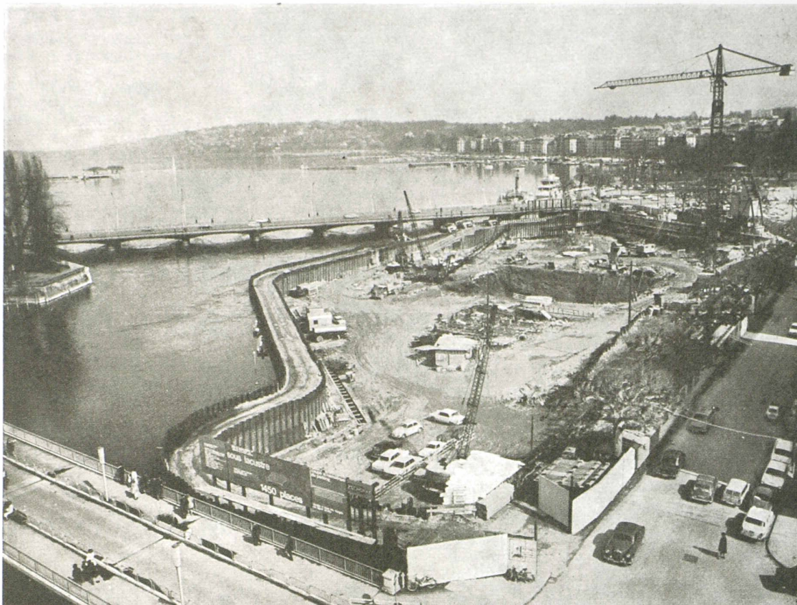
Excavation du Parking du Pont du Mont-Blanc, Genève
