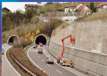
Murs de soutènement
