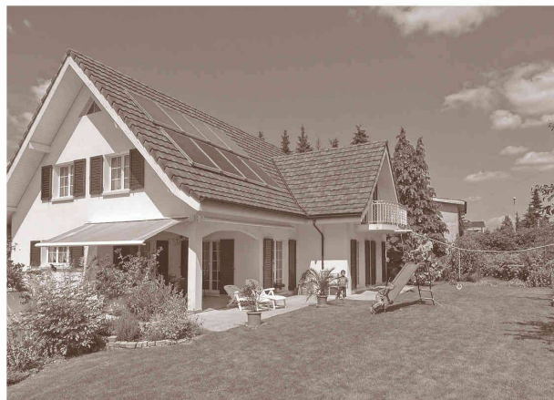
Solution idéale et éprouvée: la combinaison mazout-solaire.
