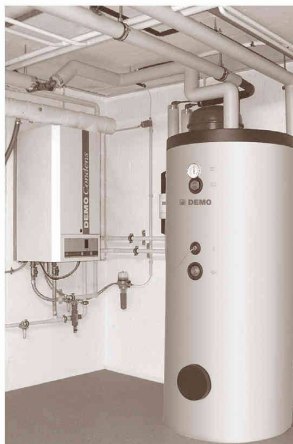
Parmi les chaudières à mazout à condensation existent aussi des chaudières murales.
