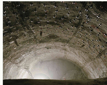
Têtes d'ancrages, Sud du tunnel de base du St-Gothard (Photo Milo Keller/FEAL)
