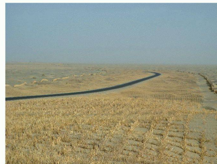
Autoroute du Taklamakan (Photo DR)
