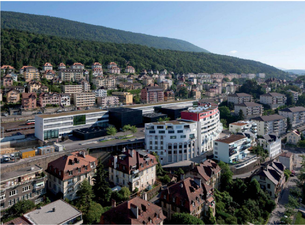
Vue aérienne du Campus Arc1 (Photo Yves André)
