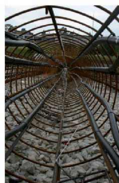
Équipement d'un pieu énergétique (Photo LMS-EPFD)
