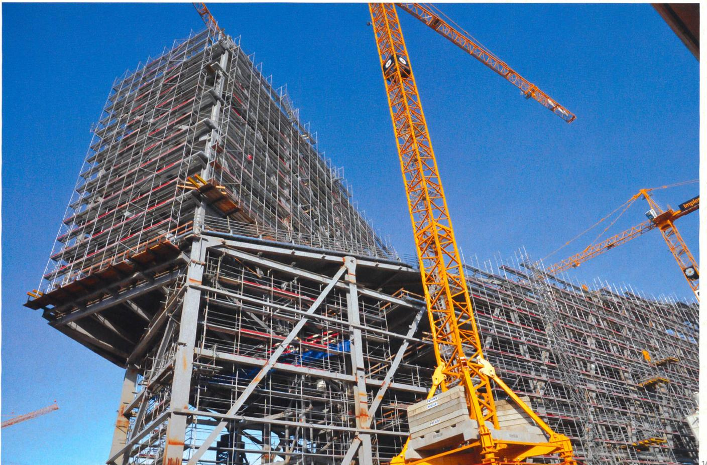
bâtiment, étaient toutes différentes (fig. 10). L'étude des nœuds a été rationalisée à travers un système de règles qui a permis de définir la géométrie des différentes catégories de connexion en garantissant une diffusion homogène des efforts dans les membrures.
