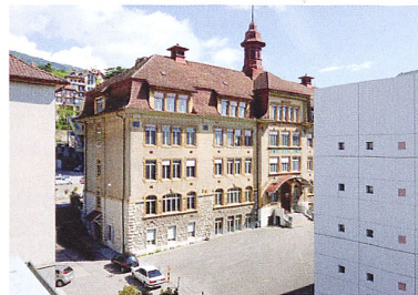
Fig. 52-53 L'ensemble du bâtiment à l'achèvement des travaux de rénovation.
