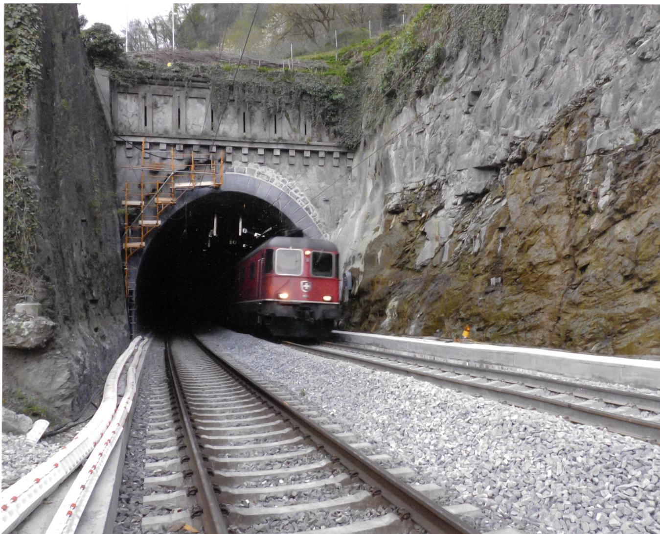
Situé sur la ligne Lausanne-Brigue et mis en service en 1859, le tunnel de St-Maurice a une longueur de 489 mètres, dont 35 de tranchée couverte côté St-Maurice. Excavé dans du calcaire, il n'est revêtu de moellons qu'au nord sur une longueur de 150 m.
