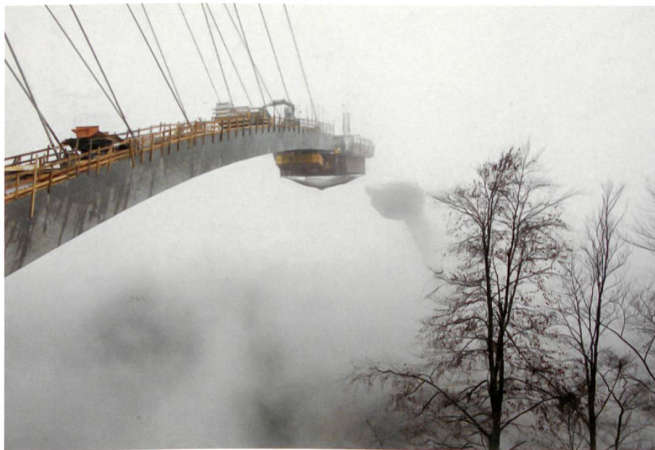
Construction en encorbellement des arcs du pont de la Tamina (photo Werner Fetzter)
