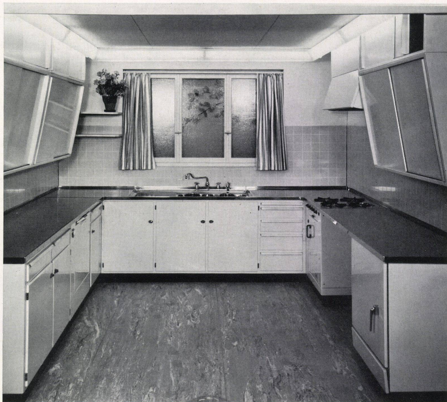
Kleinküche mit Eßtisch, der unter den Rüsttisch geschoben werden kann. Klappstühle. Arch. C. Trippel.
