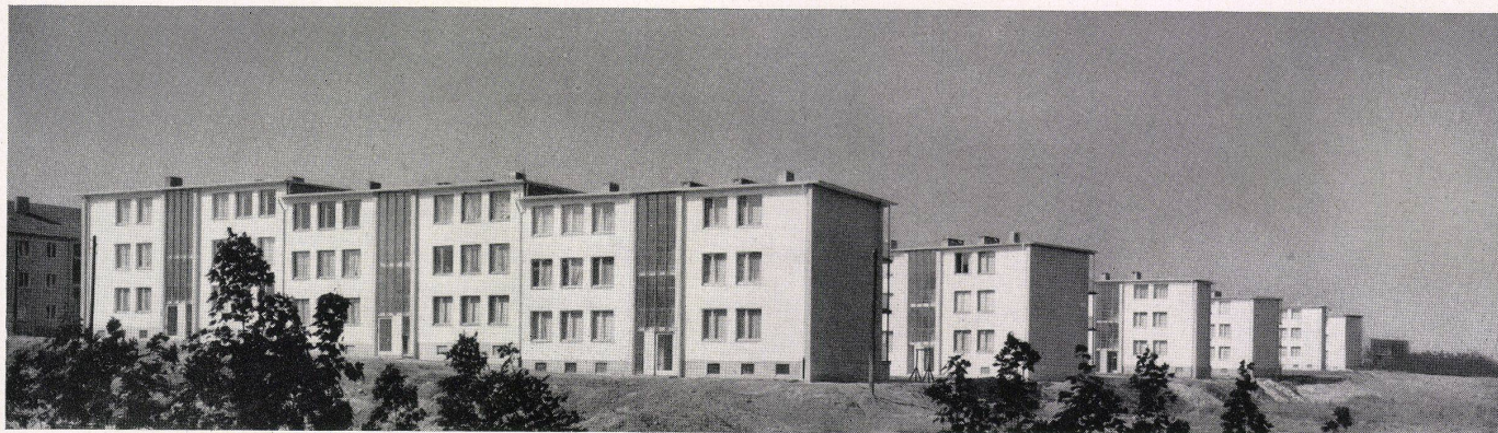
Siedlung Reuterstraße. Westansicht. Colonie «Reuterstrasse». Vue prise de l'ouest. Reuterstrasse estate. View from the west.
