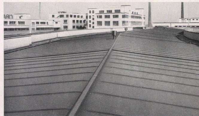
Dach eines chemischen Industriegebäudes (Ciba Basel). Die städtische Industrieatmosphäre ist erfüllt von Ruß und zum Teil recht korrosiven Chemikalien. Hier bietet das bewährte Kupfer den besten Schutz vor vorzeitiger Zerstörung.
