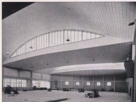
Gipsdielen als feuerschützende Verschalung in einer Großgarage
