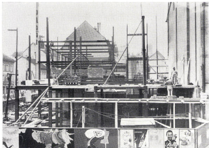
Stahlskelett zum Neubau Kleider-Frey Olten
