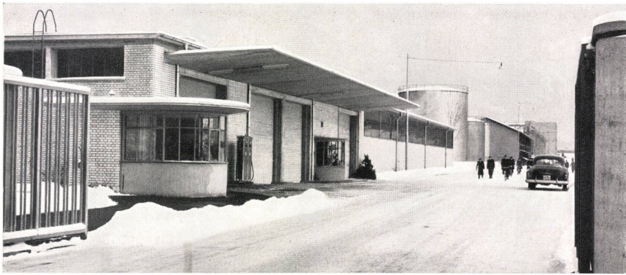
1 Werkeingang West mit Garagengebäude. Entrée ouest de l'usine avec garages. Western works entrance with garage building.
